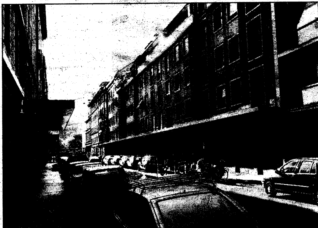
Maison des Associations. Pour l'instant, la rénovation de la façade côté «Savoises» a été repoussée à une date ultérieure.
